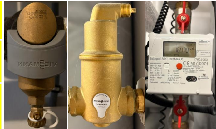
Magnetit Schlamm- abscheider Mikroblasen Laufabscheider Wärmemengen- zähler
