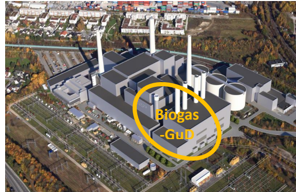
Gas- und Dampfturbinenanlage (GuD) auf Basis Biogas
