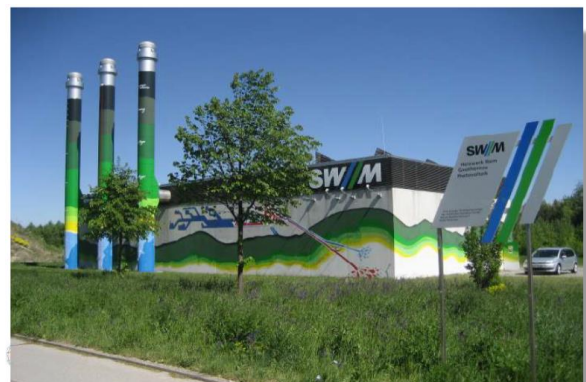
Stadtwerke München: Geothermie-Anlage Riem (Inbetriebnahme 2004)
