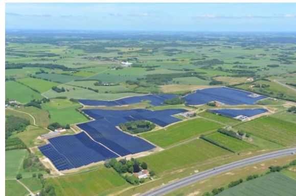
Europas größte Solarthermie-Anlage (Karlsdorf/Graz, Österreich)
