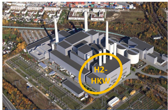
Heizkraftwerk auf Basis „grünen“ Wasserstoffs
